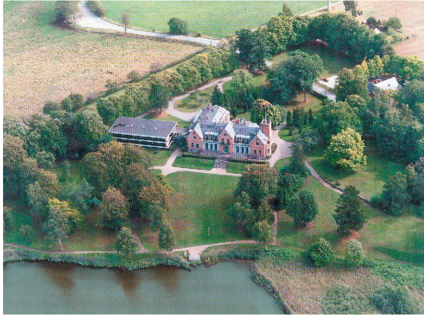
Sidebygning (betonbygning) vil blive revet ned. Gurrehus
